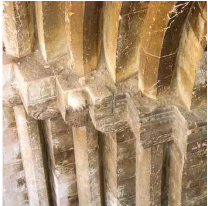
Le foto evidenziano lo stato di degrado del portale in pietra bianca, caratterizzato da una pronunciata strombatura scalata con cordoni a sezioni ottagonole, che presentava microlesioni e fratturazioni diffuse, decoesione e distacco di materiale lapideo.
