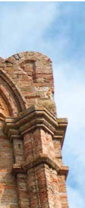
La facciata presentava un avanzato degrado del paramento murario con perdita di malte dei giunti di connessione, cavità e perdita di elementi costitutivi e presenza di piante infestanti, muschi e licheni.
