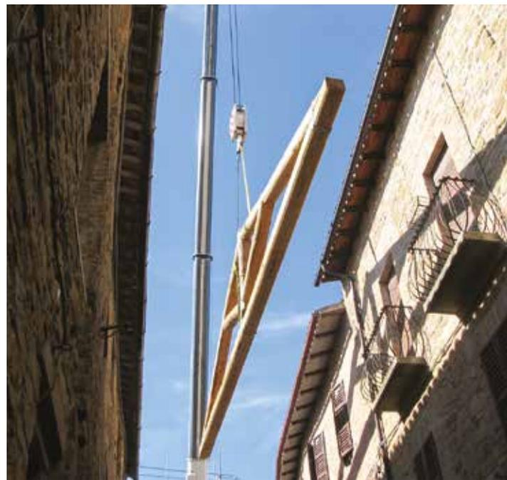
Le foto mostrano la particolare difficoltà operativa dovuta agli spazi limitati per il posizionamento, mediante l'ausilio di autogru speciali, delle nuove capriate sul tetto della chiesa.
