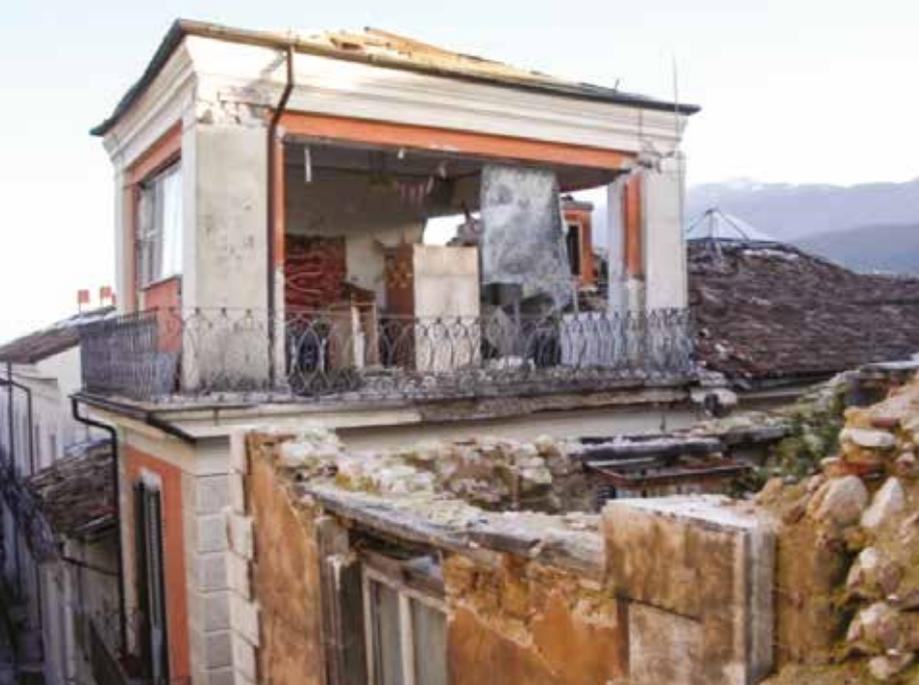
Particolare relativo allo smontaggio eseguito manualmente con l'ausilio di gru speciali di un altana, del peso di 40 tonnellate, pericolante nei pressi di piazza Duomo a l'Aquila e qui in basso al termine dei lavori di messa in sicurezza.
