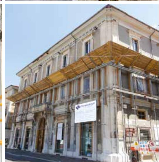
Le foto evidenziano la messa in sicurezza degli edifici relativi a via Cimino e via Sassa eseguite con strutture di acciaio UPN certificate appoggiate sulle murature esterne e contrastate tra loro mediante tiranti orizzontali per garantire la tenuta delle facciate contro fenomeni di ribaltamento.
