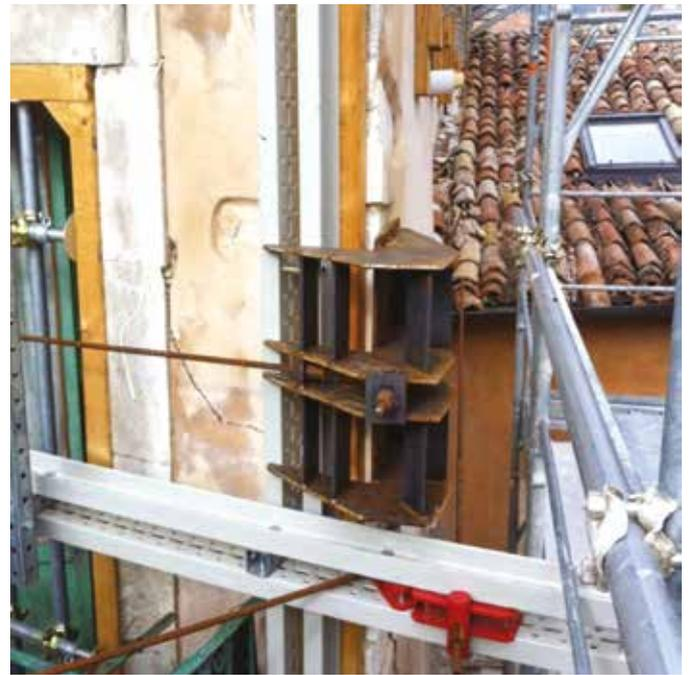
Via Sassa, Palazzo Franchi, realizzazione struttura a tubo e giunti di sostegno facciate dell'edificio.
