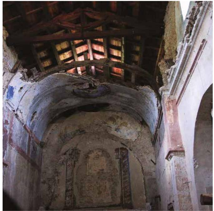
Veduta della volta danneggiata a causa delle infiltrazioni meteoriche e al termine dei lavori di consolidamento e restauro.
