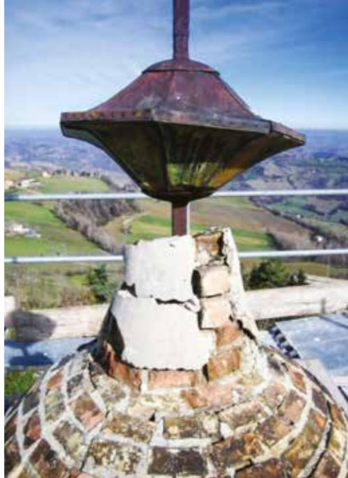
Vista della torre campanaria che presentava un diffuso degrado con perdita di malta dai giunti di connessione, frattura e distacco di elementi in cotto, notevole presenza di erbe infestanti. Sotto la torre al termine dei sapienti lavori di consolidamento e restauro.
