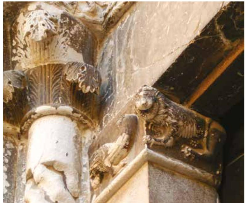
A sinistra lo stato di degrado del portale con evidenti microlesioni del materiale lapideo ed alterazione cromatica dovuta alla formazione di depositi e incrostazioni.
