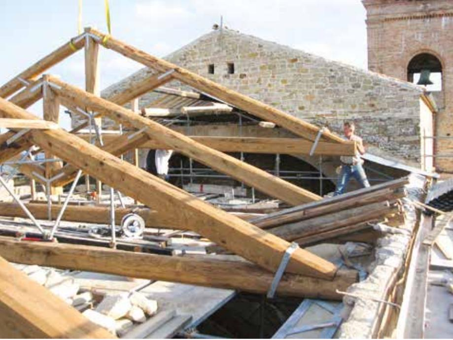
Realizzazione della nuova orditura in castagno e particolare del cordolo metallico inserito nella muratura per il miglioramento antisismico.
