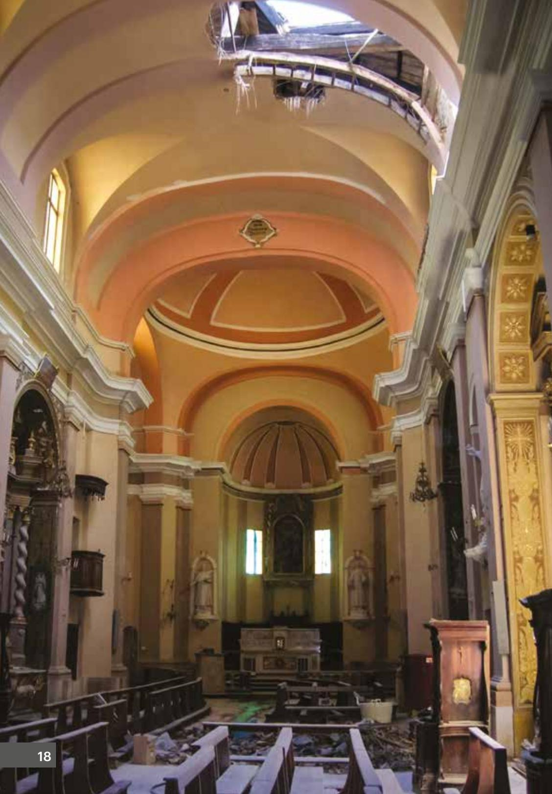
Le foto evidenziano il cedimento strutturale in copertura di una capriata con il conseguente crollo della volta in camorcanna e caduta di materiale a terra.
